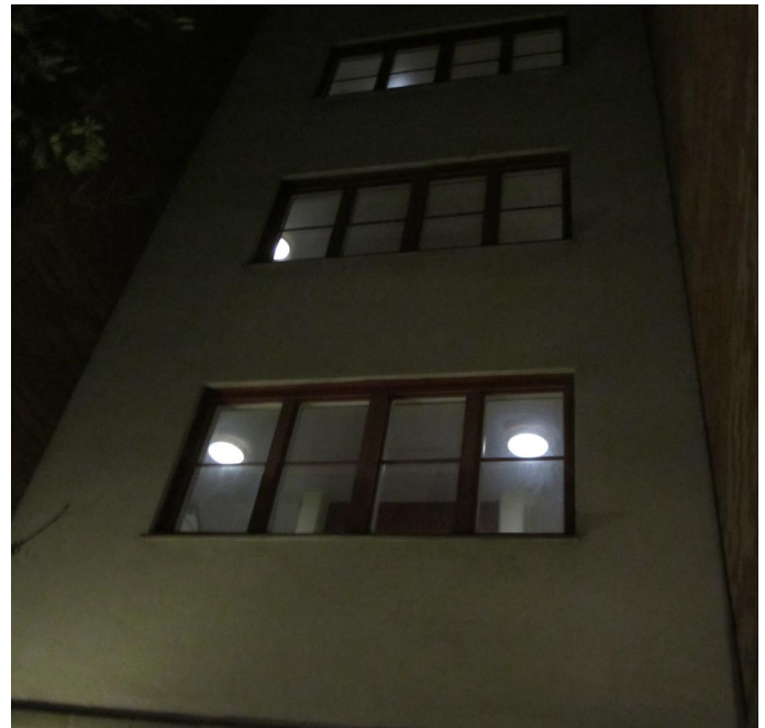
Trapphus på Östra Kvarngatan i Nyköping. Väl upplyst till en bråkdel av driftkostnaden tack vare modern LED-teknik.
