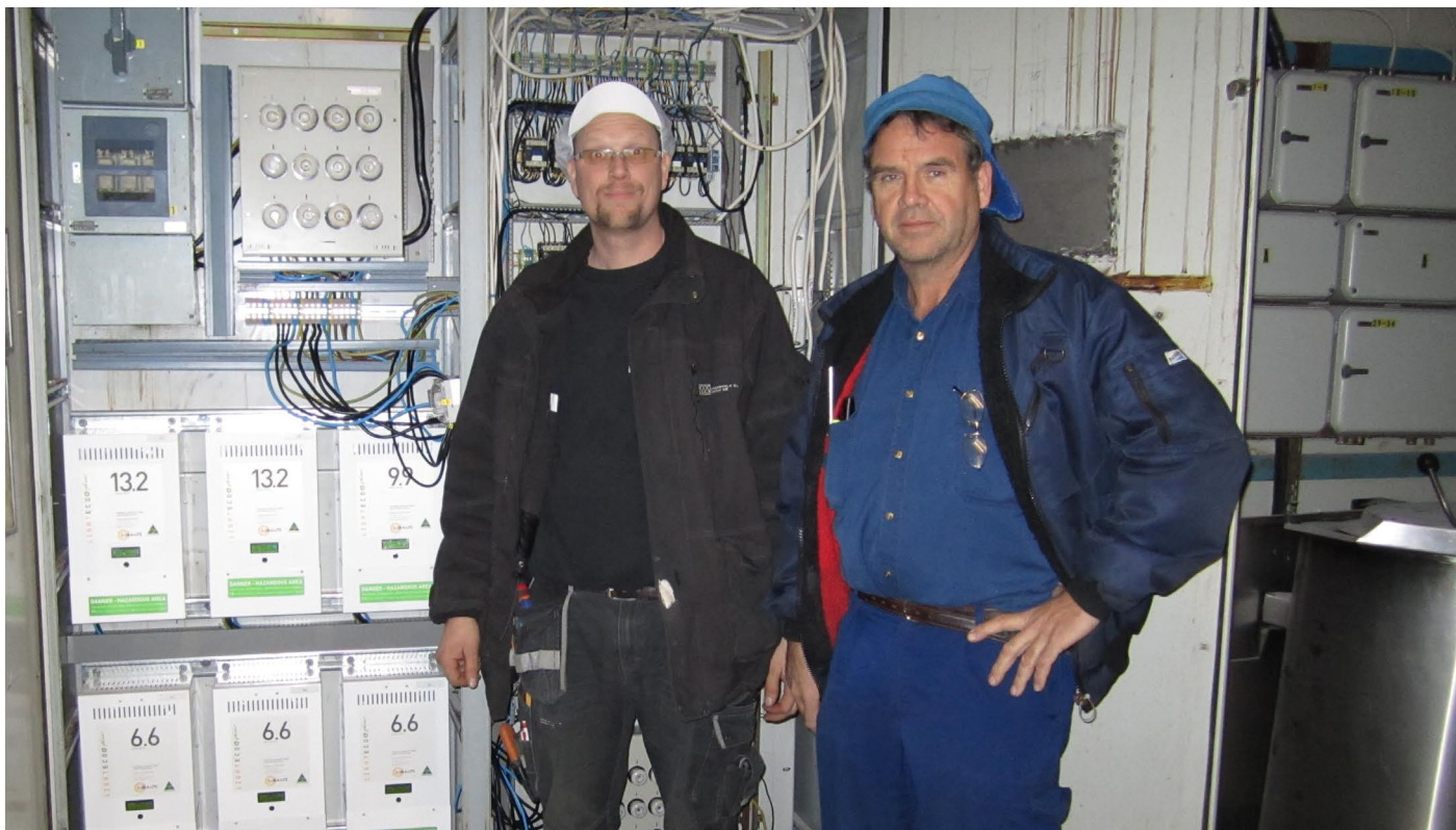
Mikael Jansson, Bergendahls El och Per Christoffersson, Göteborgs Kex framför Light Eco-installationen vid elcentralen. FOTO: Energisystem
